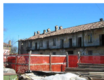
Fig. 6: I lavori di ristrutturazione del 3° lotto sono in fase di avvio
