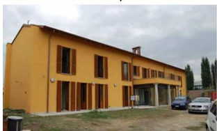
Fig. 2: Primo lotto dei lavori (completato)
